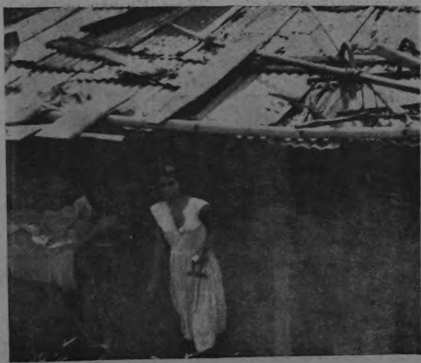
Esta mujer aplancha la ropa al aire libre por cuanto la lobreguez del tugurio no le permite hacerlo dentro de la vivienda. Nótese el estado del techo de esta vivienda.
